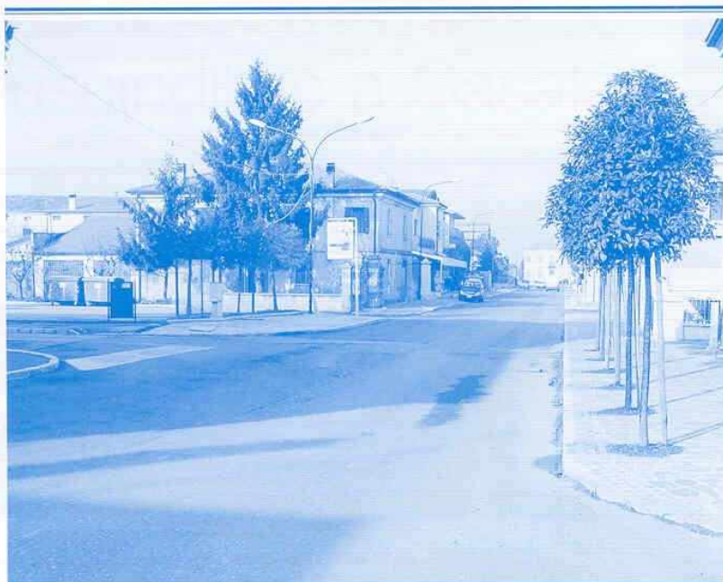
La via centrale di Sustenza dopo i lavori di rifacimento dei marciapiedi e del manto stradale
